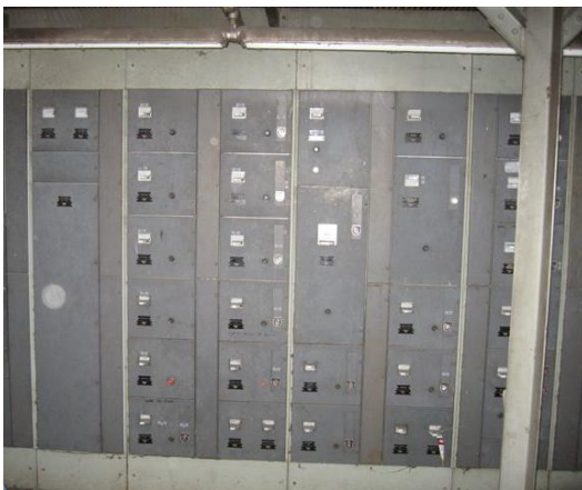
Switchgear / MCC
