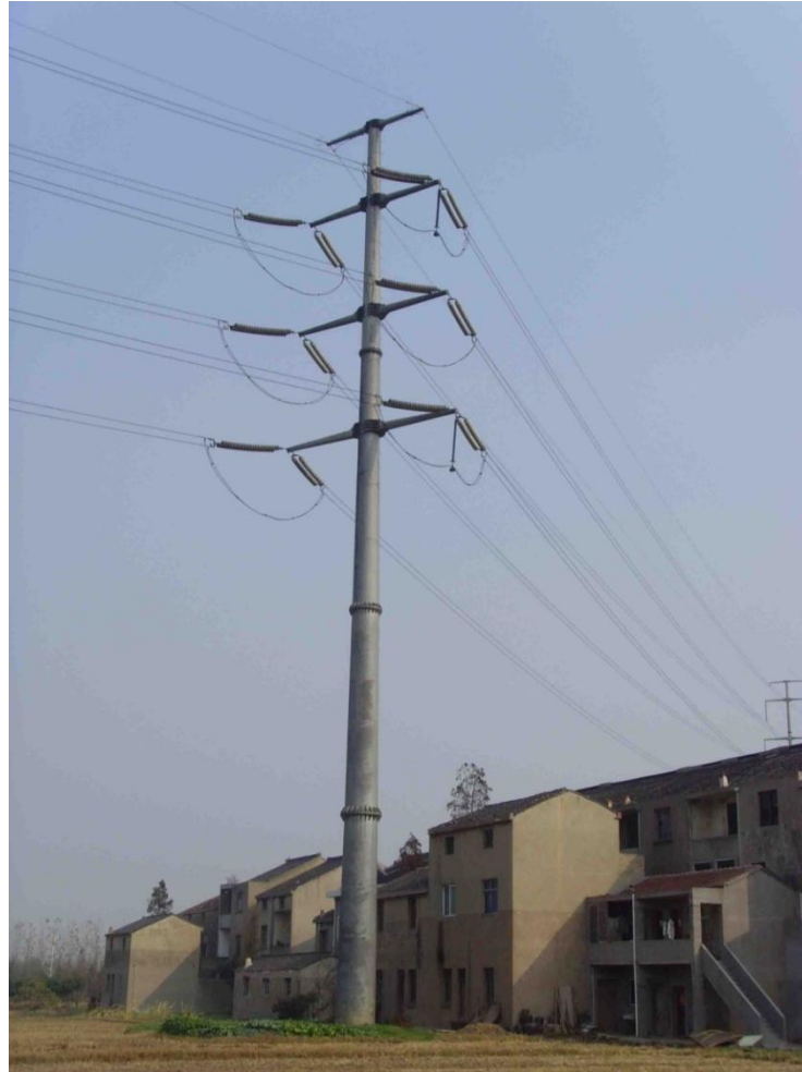
Fig: Steel Poles
