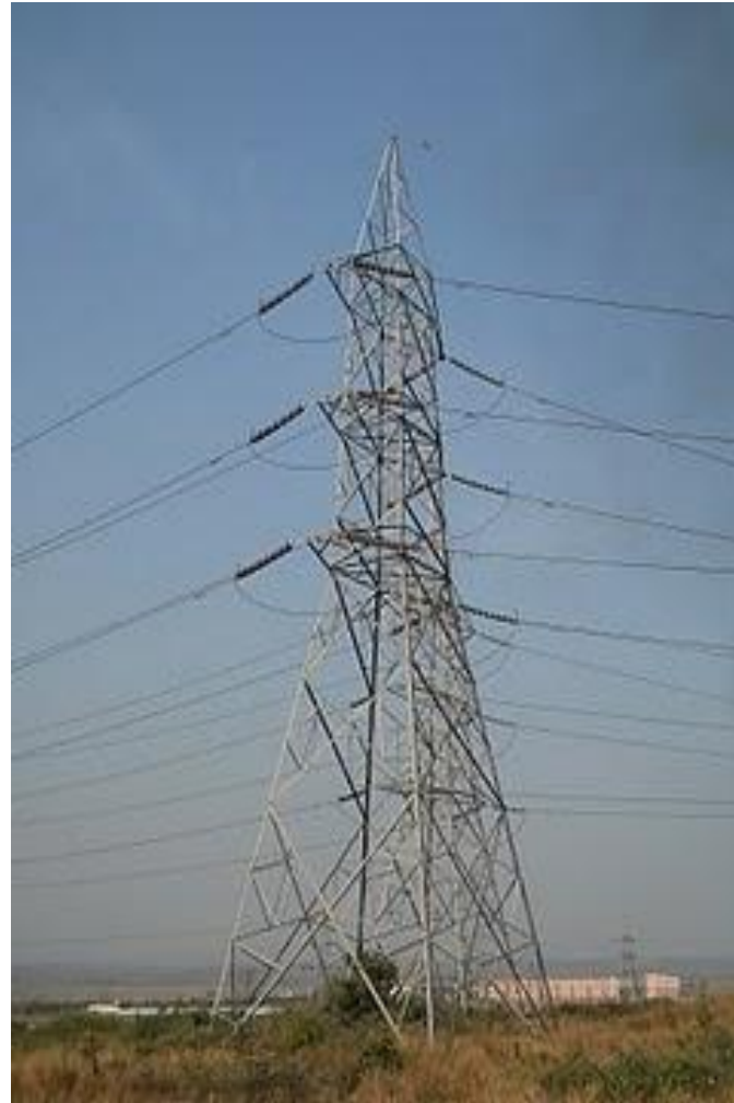
Fig: Angle Tower
